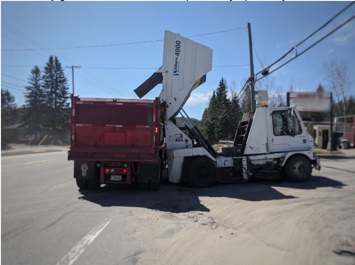
BV : Sur le territoire de la Direction générale des Laurentides-Lanaudière, le Ministère s'assure de récupérer les débris et la poussière après le balayage.
